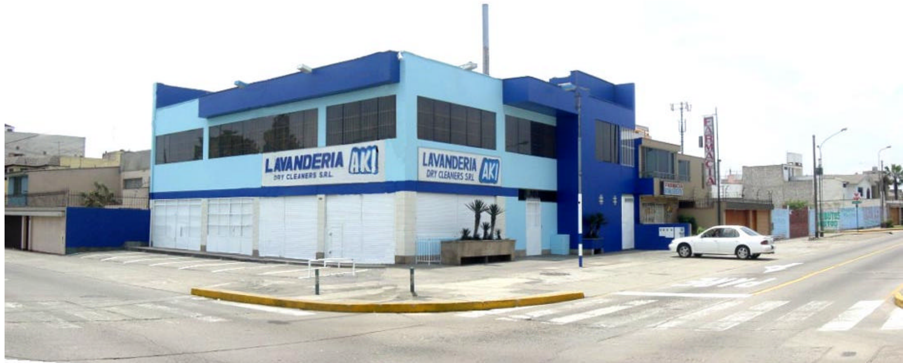
Ubicación de Local Principal: Avenida San Borja Norte 399, San Borja, Ciudad de Lima.
