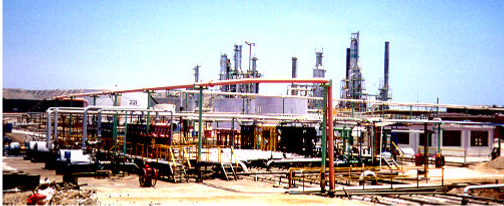
Fig. 1.- Vista de Zona Casa de Bombas 5 - Refinería Talara – PetroPeru.
