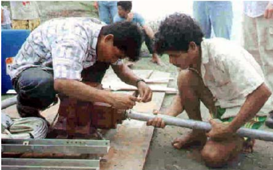
Foto N° 1 Equipo donado por TES, montaje del generador
